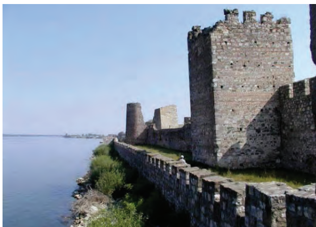
Ziduri ale cetății Sirmium
